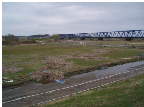
写真 2.6.2-3 高水敷グラウンドと漂流物
