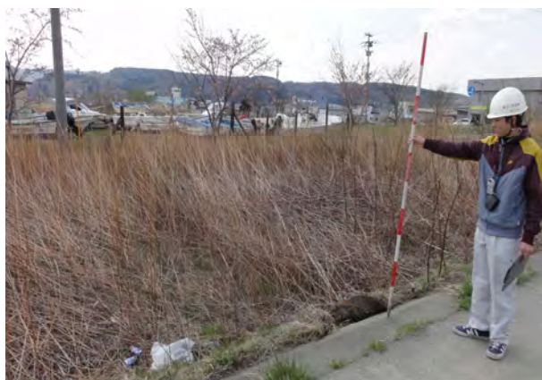
写真 2.1.1-5 湊橋付近の天端沿いの植生の倒木
