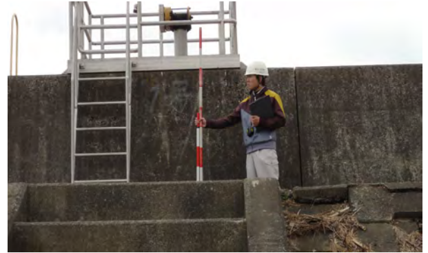
写真 2.1.1-10 小水路の排水水門
