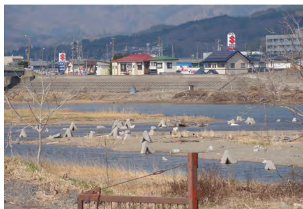
写真 2.1.1-6 テトラポットの散乱と樹林の浮遊物
