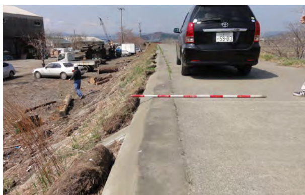
写真 2.1.1-1 のり面植生と越流の痕跡
