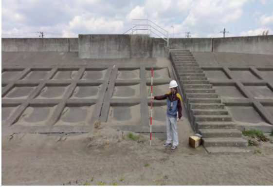
写真 2.1.1-7 表のり枠に土砂が多数付着
