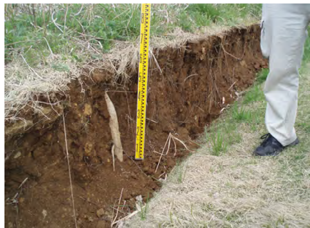
写真 2.1.1-5 左支川の中丸川堤防のブロック付マットの剥離 写真 2.1.1-6 中丸川右岸の縦断陥没と根茎
