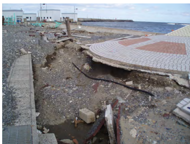
写真 2.1.1-1 那珂湊臨海公園の多数の陥没
