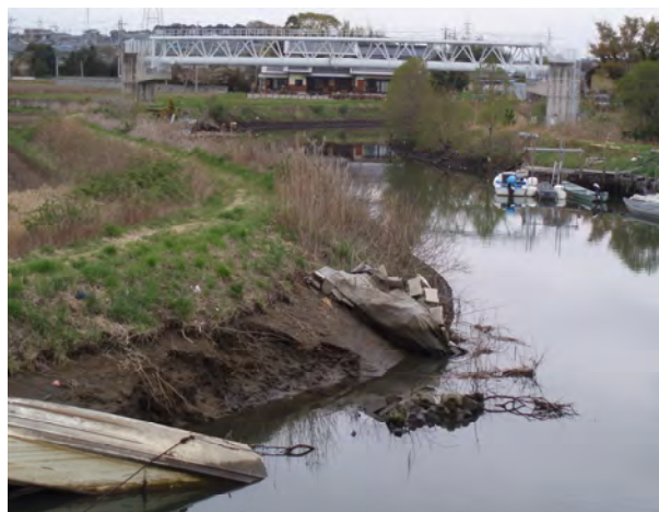
写真 2.1.1-5 左支川の中丸川堤防のブロック付マットの剥離 写真 2.1.1-6 中丸川右岸の縦断陥没と根茎
