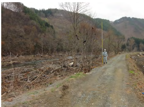
写真 2.1.2-12 河道内樹林の倒木と漂流物
