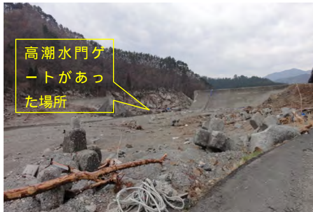
写真 2.1.2-8 破堤された高潮水門ゲート
