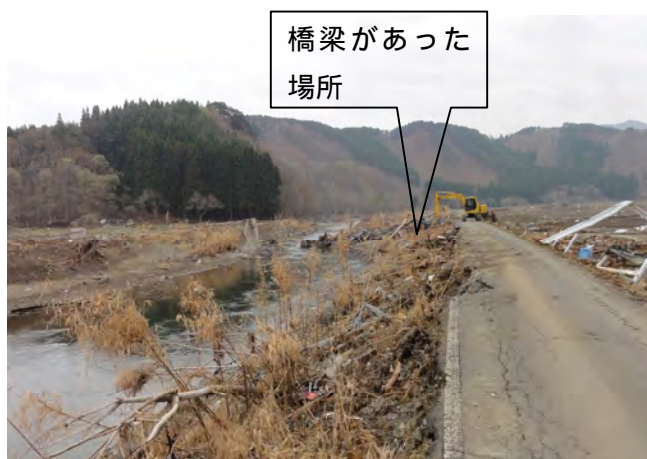
写真 2.1.2-10 最下流の橋梁の崩落
