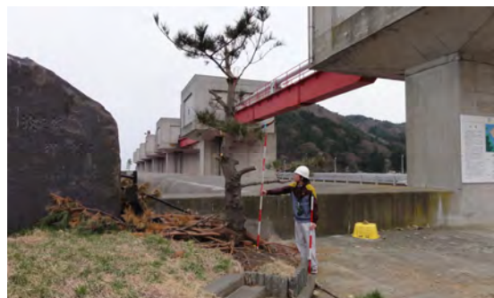
写真 2.1.2-1 小本川水門と痕跡
