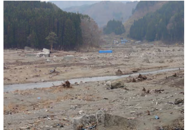
写真 2.1.2-9 散乱するゲートとテトラポット
