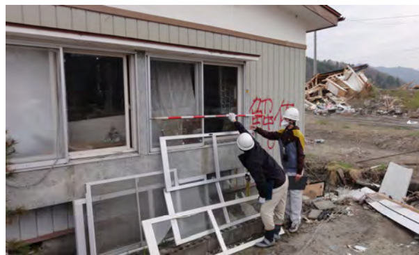
写真 2.1.5-7 護岸近くの全壊した民家
