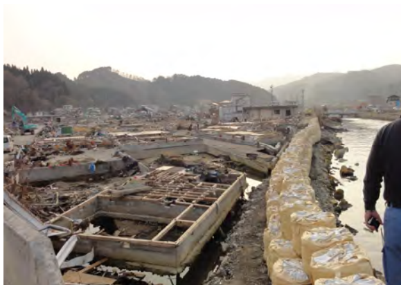
写真 2.1.5-3 右岸崩壊・護岸の応急復旧
