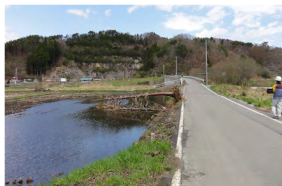
写真 2.1.6-14 根井沢橋上流に越えた漂流樹木
