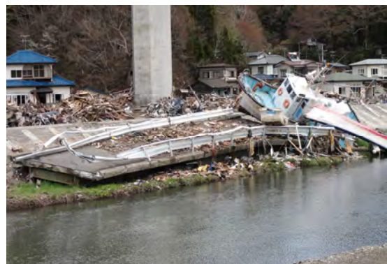
写真 2.1.6-10 津波に運ばれた橋桁と漁船
