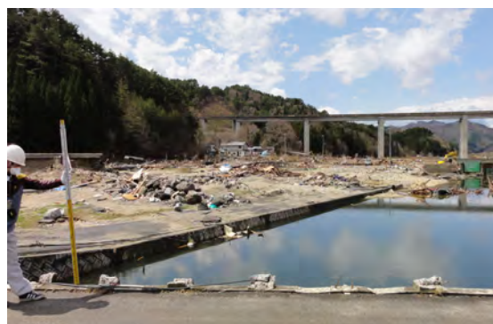
写真 2.1.6-4 J R山田線の鉄道線路の損壊
