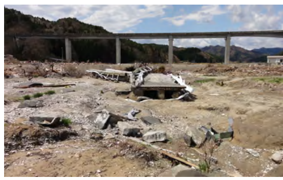
写真 2.1.6-6 約 90m 上流に流された橋桁
