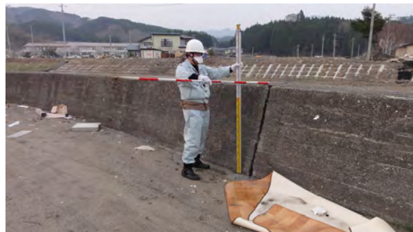
写真 2.1.5-6 崩壊付近の護岸高 H=1.6\text{m}
